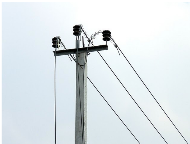
Zdjęcie słupa energetycznego z uszkodzonymi linkami z galerii Amielina
